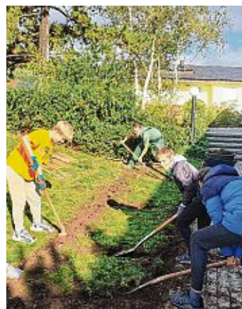
Im Außenbereich wurde fleißig das Fundament für das Insektenhotel und das Beet angelegt.
